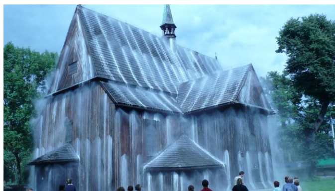
Fot. 7 Test funkcjonalny działania instalacji mgły wodnej wraz ze środkiem spieniającym.
