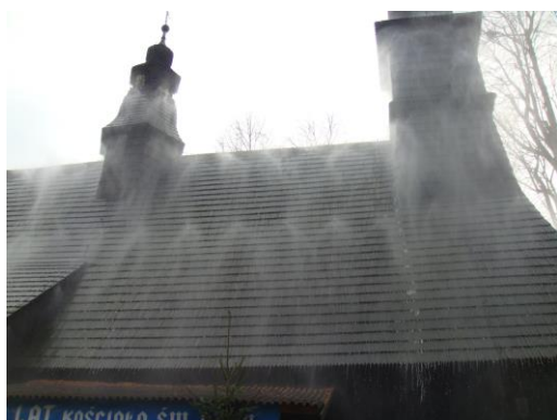
Fot. 5 Test funkcjonalny działania instalacji mgły wodnej.
