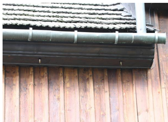
Fot. 3 Dysza mgłowa wraz z detekcją linową po montażu zainstalowana pod okapem
