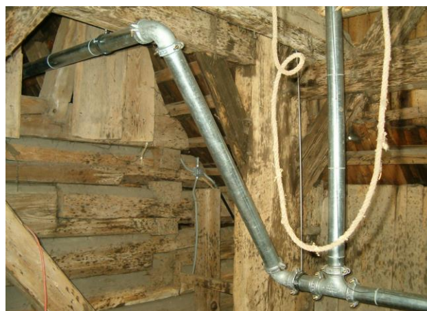
Fot. 1 Rurociągi rozprowadzające na strychu kościoła prowadzone bez naruszenia konstrukcji więźby dachowej.
