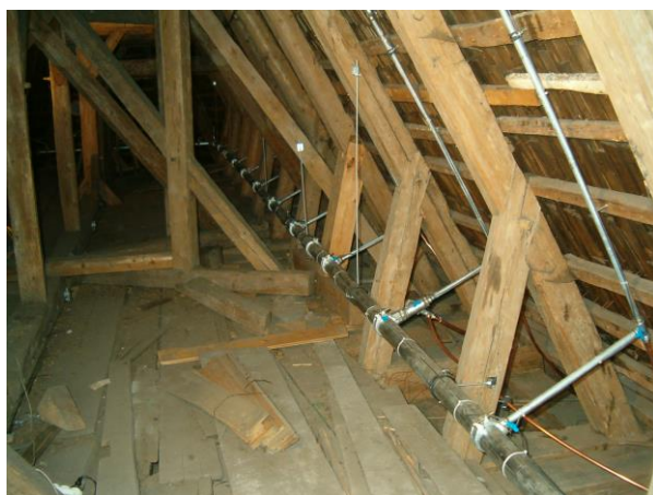
Fot. 2 Rurociągi rozprowadzające i gałązki zasilające na strychu kościoła prowadzone bez naruszenia konstrukcji więźby dachowej.
