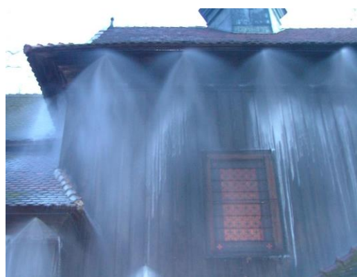
Fot. 6 Test funkcjonalny działania instalacji mgły wodnej wraz ze STHAMEX-em.
