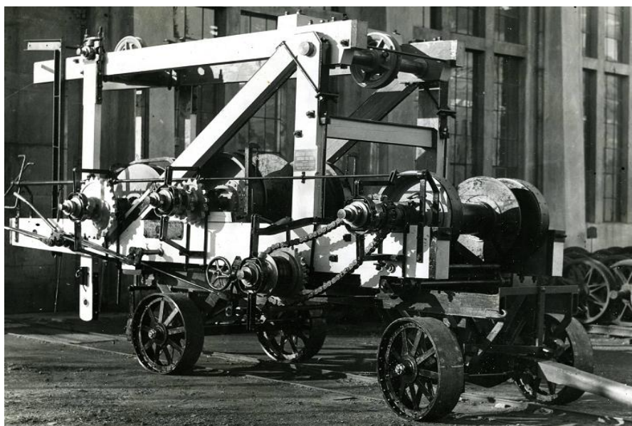
Ilustracja 87, wiertnica przewoźna – typ SM-3 produkcji Fabryki Maszyn „Glinik” (rok produkcji 1947) Muzeum PTTK w Gorlicach, zbiory archiwalne
